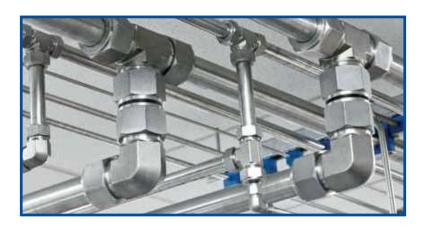
Par rapport à un système de tuyauterie de puissance comparable, les systèmes utilisant des tubes sont beaucoup plus légers. Cela signifie qu'ils sont plus faciles à installer et à soutenir.
